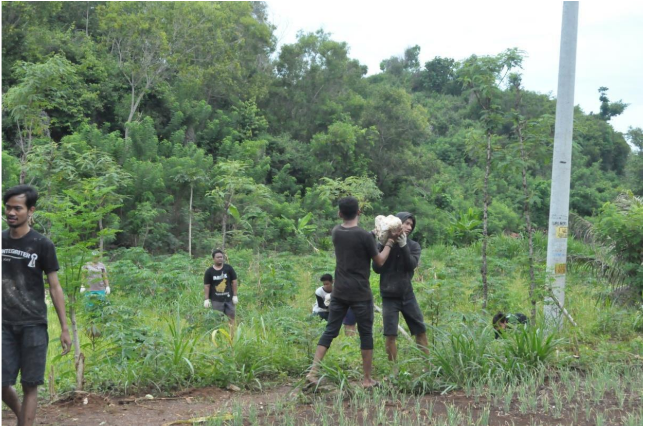
Gambar: Kegiatan pembuatan pondasi rumah pompa
