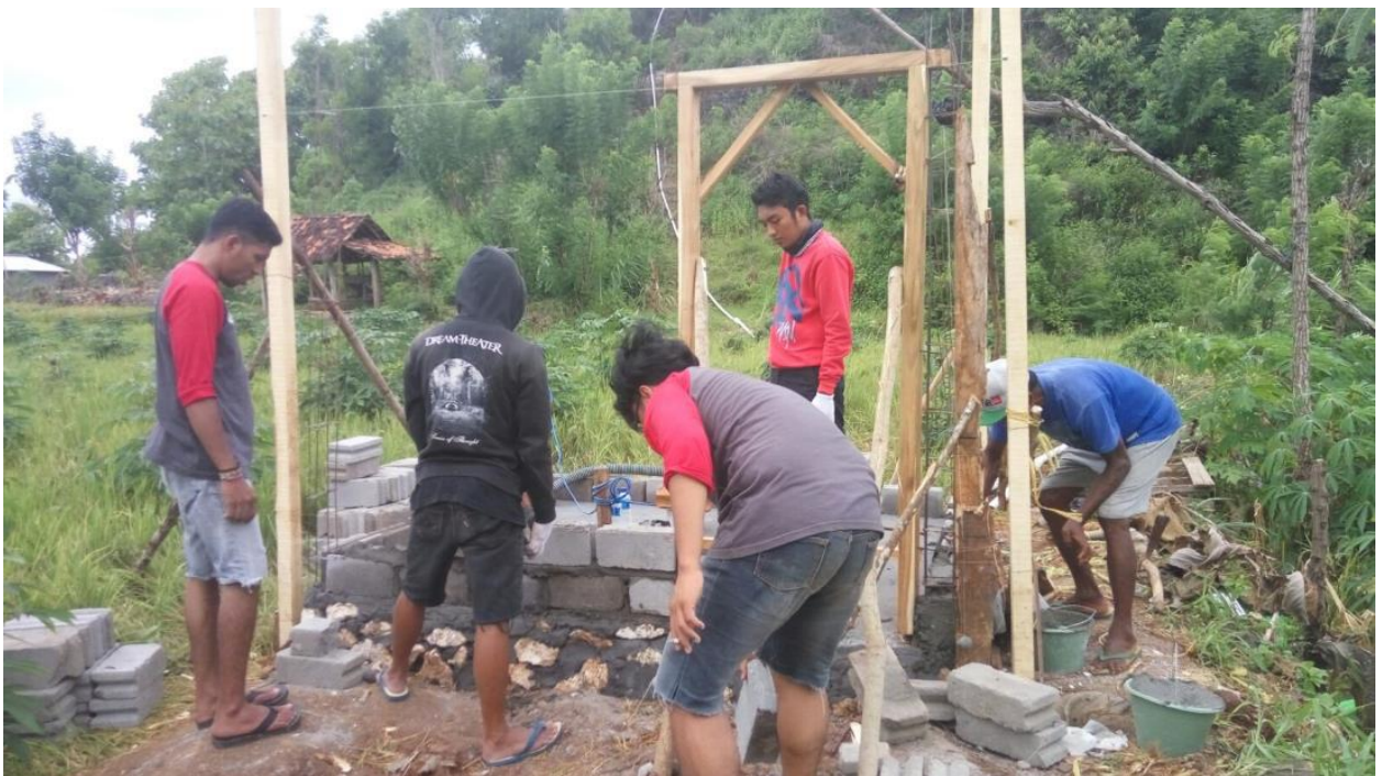
Gambar: Kegiatan pemasangan dinding rumah pompa
