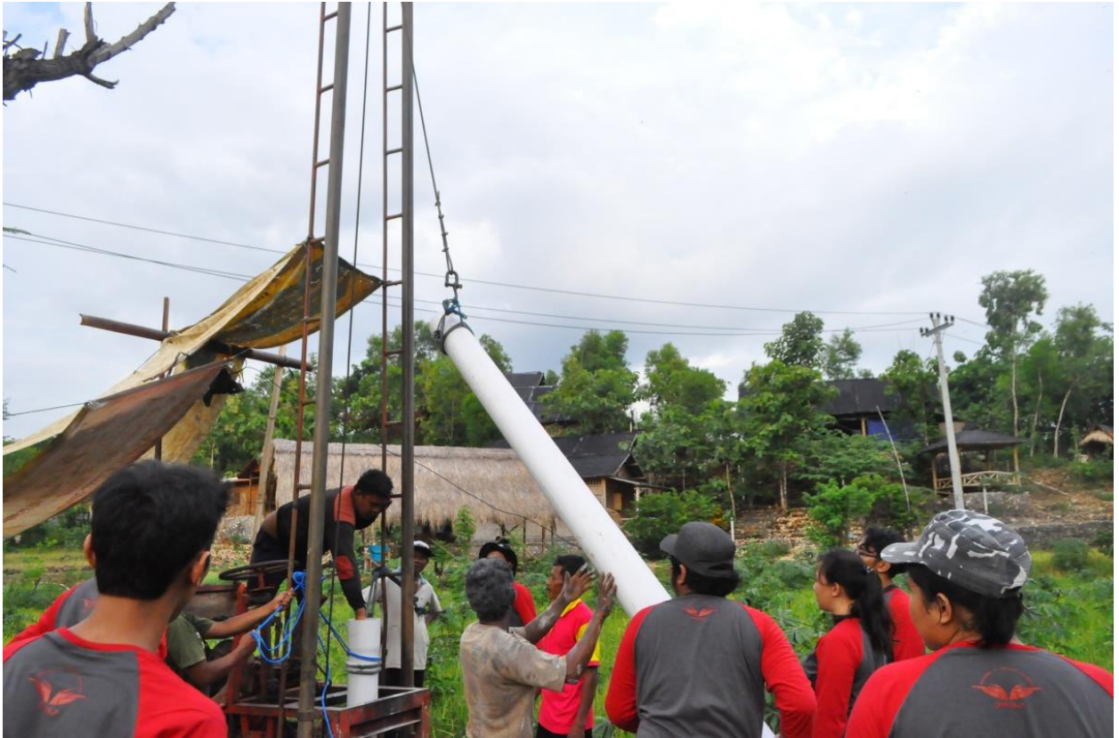
Gambar : Pekerjaan pemasangan pipa di sumur
