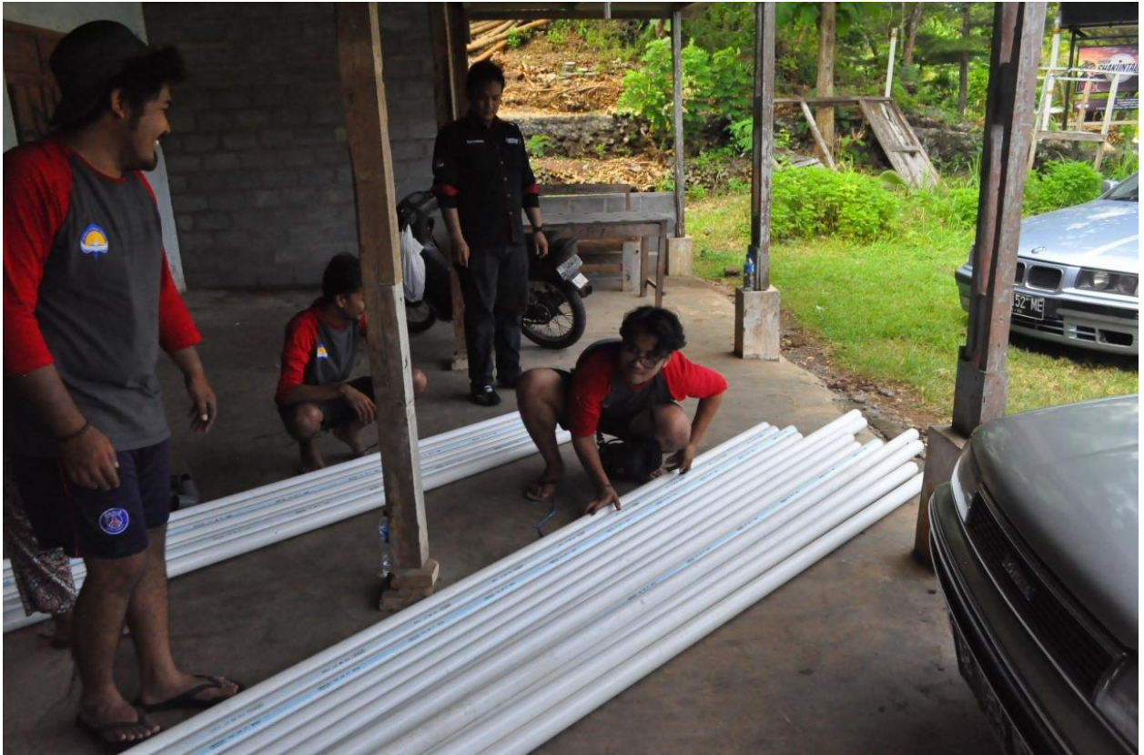
Gambar : Mempersiapkan material pemasangan pipa
