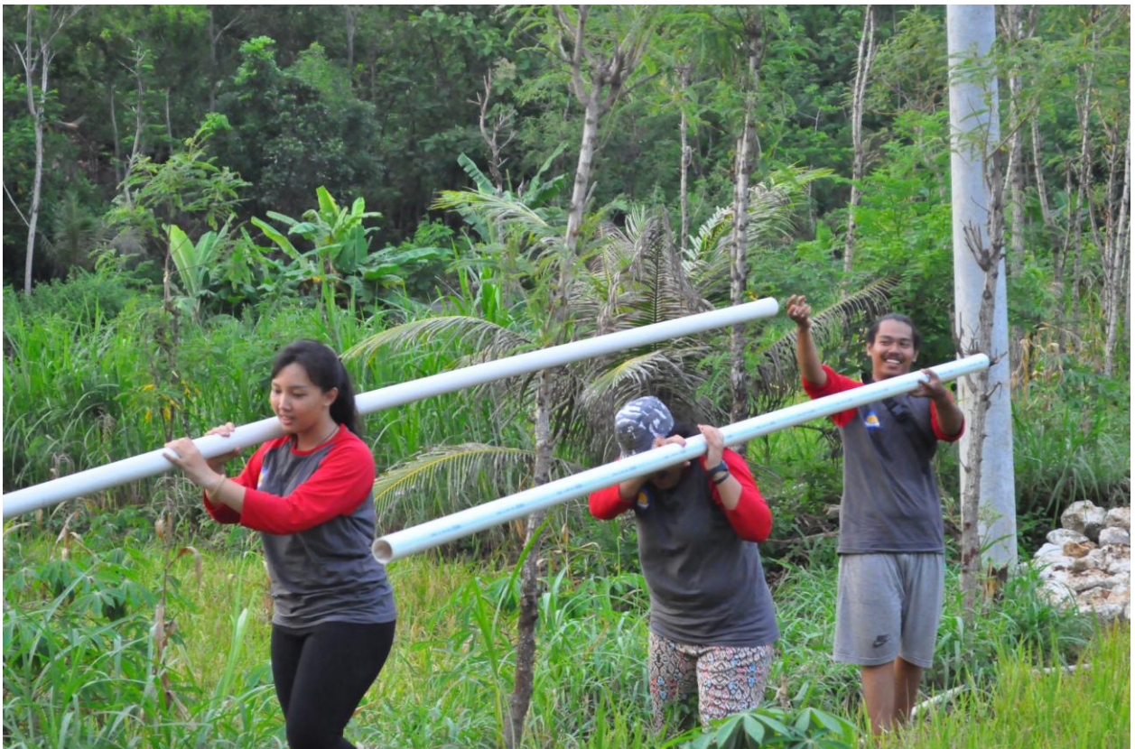
Gambar : Mempersiapkan material pemasangan pipa
