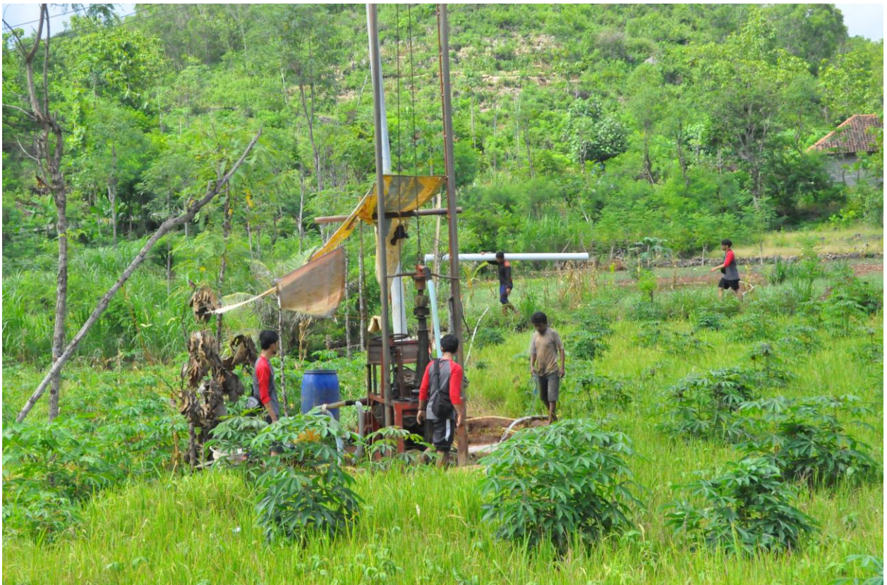
Gambar : Pekerjaan pemasangan pipa di sumur
