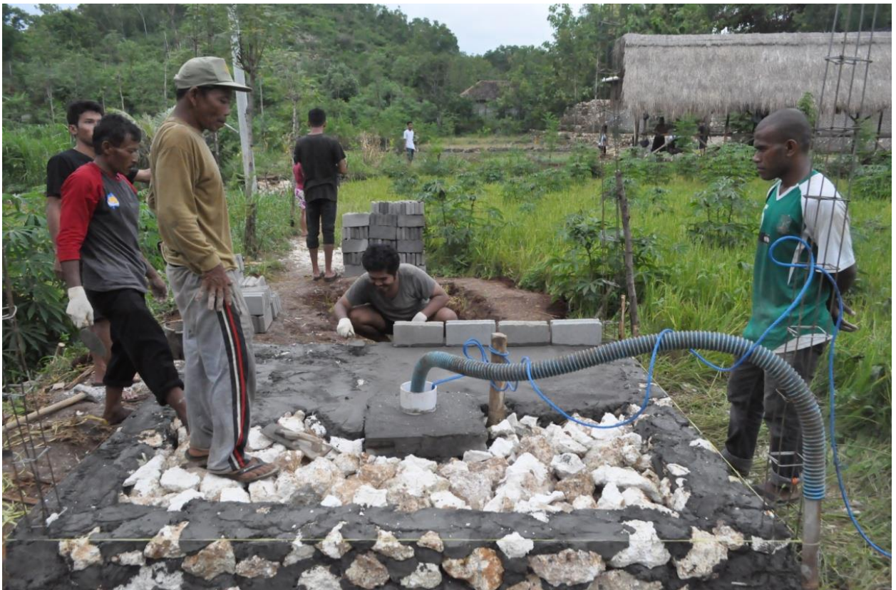
Gambar : Kegiatan pembuatan lantai rumah pompa
