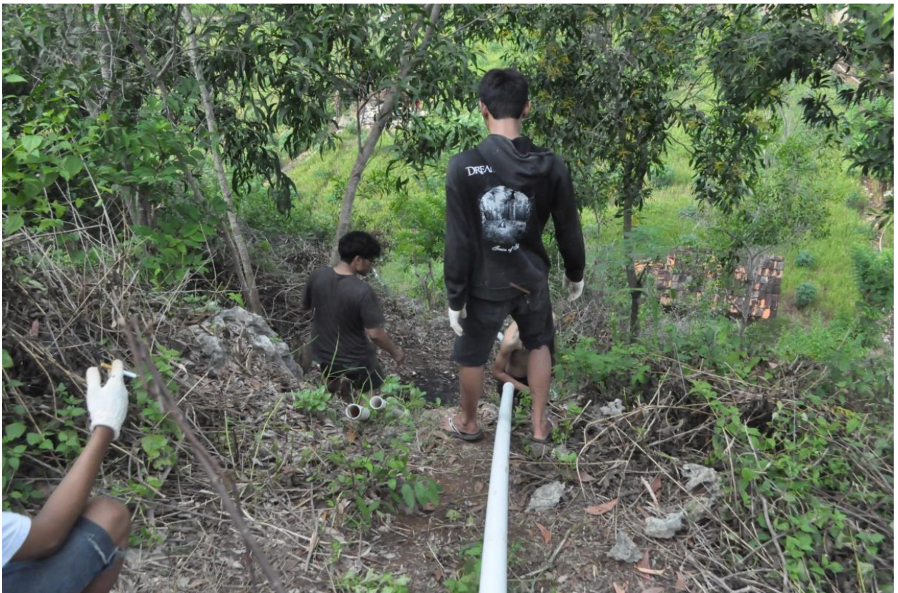
Gambar: Kegiatan pemasangan pipa menuju bak penampungan
